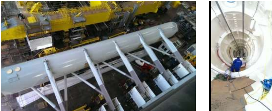
Figuur 6: Assemblage totale installatie bij Huisman (Schiedam)
