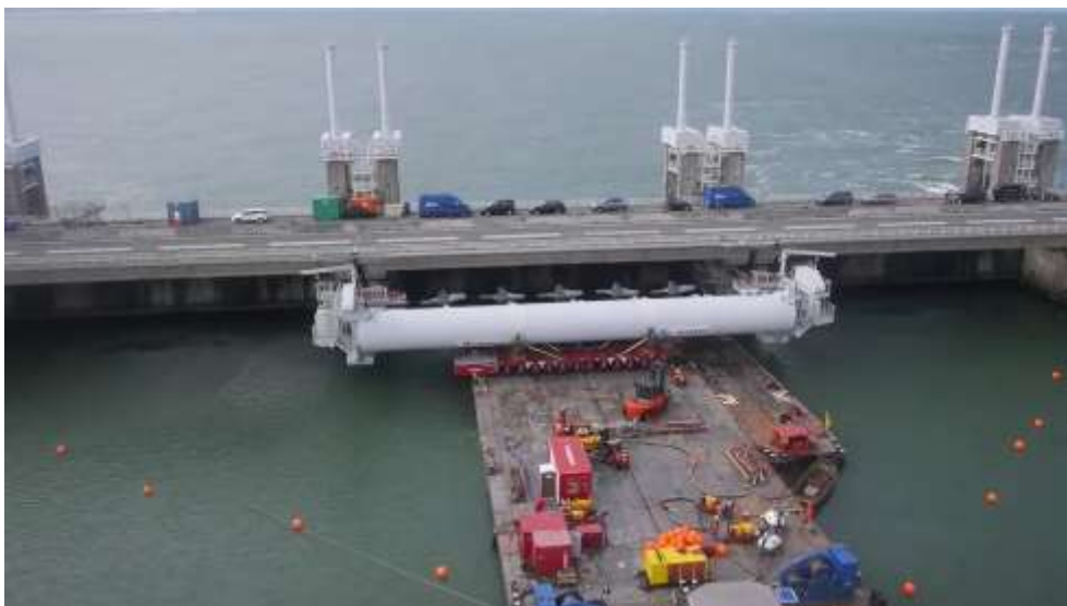
Figuur 10: Installatie bijna geplaatst
