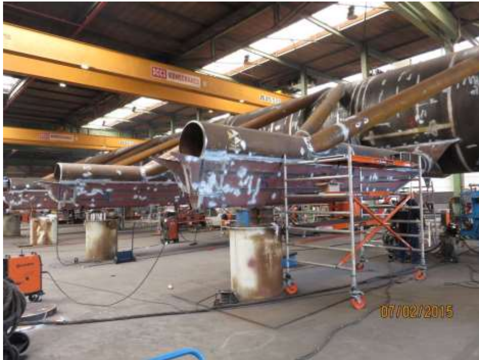
Figuur 4: Bouw van de fundatie bij Hillebrand
